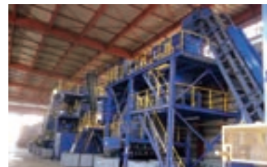
ASR再資源化施設
