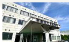
日東化工(株) 本社・湘南工場
