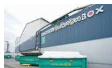
(株)エコネコル 松本工場
