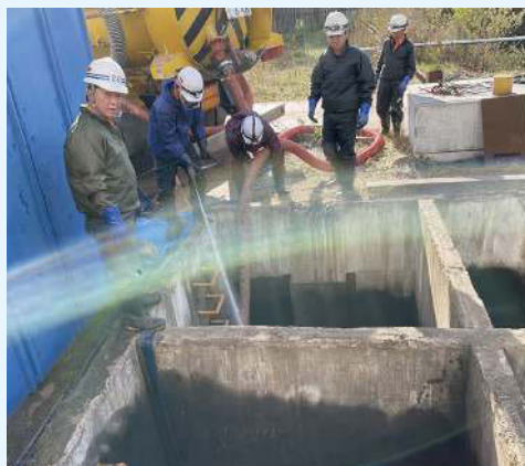
油水分離槽清掃
