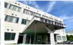
日東化工(株) 本社・湘南工場
