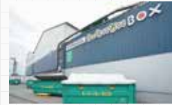
(株)エコネコル 松本工場
