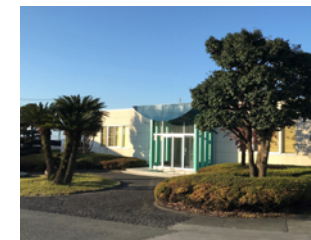
④ (株)東洋ゴムチップ 本社工場
